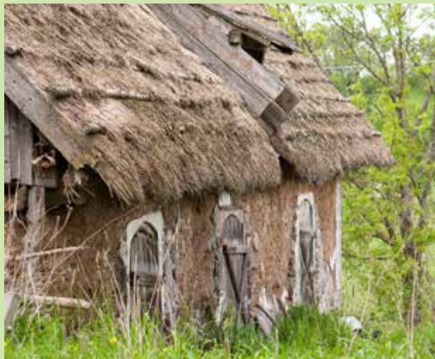
Wodziłki – budynek z gliny (TŚ)
